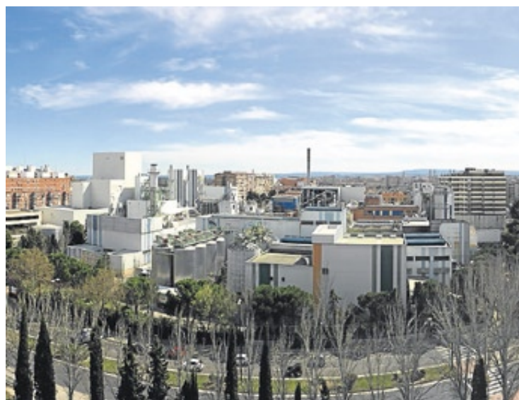
Instalaciones. Planta de transformación de la firma en Zaragoza.
